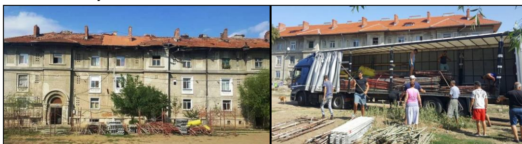
Foto: repararea acoperisului blocului ghetou din Alea Carpati, Caracal
